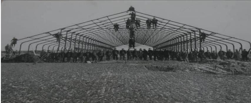
Bygget av dåtidens största växthus väckte stor uppmärksamhet – och krävde många arbetare.
